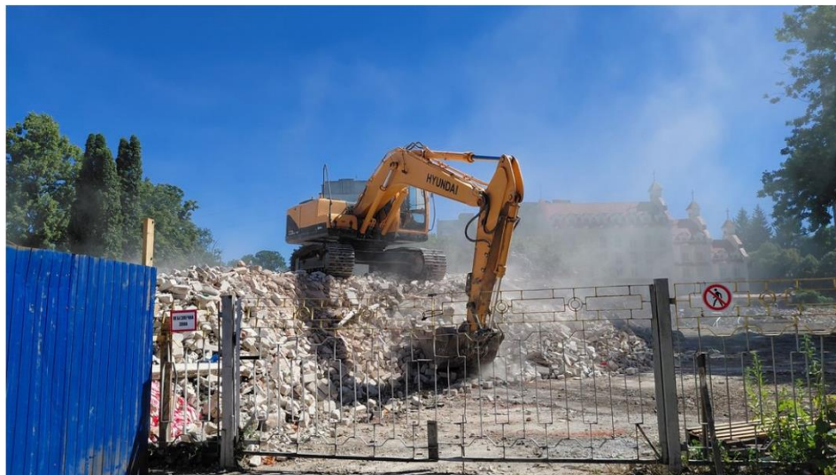
Рис. 3.2.3.1 Процес знесення будівлі ліцею № 25 Джерело: Суспільне Житомир/Ірина Остапчук
